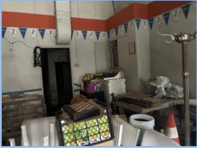
Zemin Kat Görünüm
