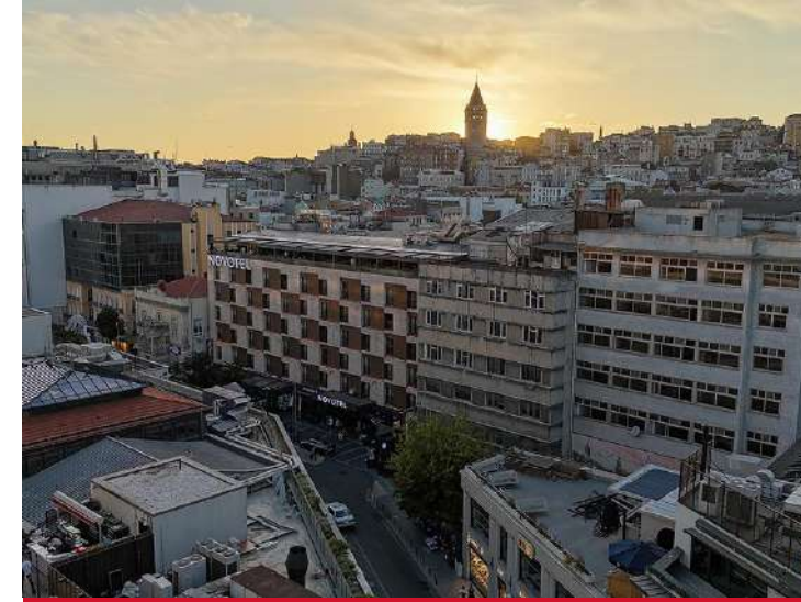
Tahir Han Ofis Binası
